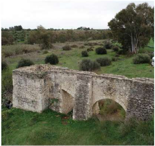
Αποψη του νερόμυλου από κατασκευαστικά όργανα διακρίνονται τα υδραγωγεία και ο υδατόπυργος.
