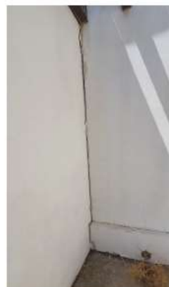
Φ.6, Φ.7: Έντονες κατακόρυφες ρωγμές που σχίζουν την τοιχοποιία σε όλο της το πάχος, ενώ ξεκινούν από τη στέψη οροφής και καταλήγουν στα θεμέλια. Οι εν λόγω ρωγμές παρατηρούνται στις γωνίες και στα σημεία ενώσεων με τους εγκάρσιους τοίχους αποτέλεσμα απουσίας περιμετρικού διαζώματος και ανεπαρκούς σύνδεσης μεταξύ εγκάρσιων τοίχων. Στη Φ.7 η ρωγμή φαίνεται να προκαλεί στροφική απόκλιση από την κατακόρυφο.
