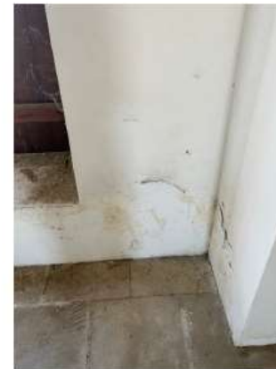
Φ.5, Φ.6: Εκτεταμένα προβλήματα ανιούσας υγρασίας με αποτέλεσμα το φούσκωμα, αποφλοιώση και την τοπική αποκόλληση του επιχρίσματος εσωτερικά του κτηρίου. Στη φωτογραφία δεξιά, ο τοίχος κάτω από τη σκάλα εφάπτεται της εξωτερικής σκάλας από φυσικό λίθο (βλέπε επόμενη Φ.7) η οποία εξωτερική σκάλα από πέτρα, φαίνεται να εγκλωβίζει την υγρασία η οποία εκτονώνεται στον τοίχο.
