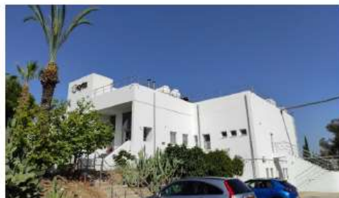
Φ.2: Άποψη Νότιας / Ανατολικής όψης.
