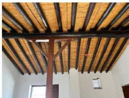
Φ.13: Λεπτομέρεια νέας ξύλινης οροφής εντός ενός από τα δωμάτια της οικοδομής που υλοποιήθηκε όταν έγιναν οι εργασίες αποκατάστασης το 2008.
