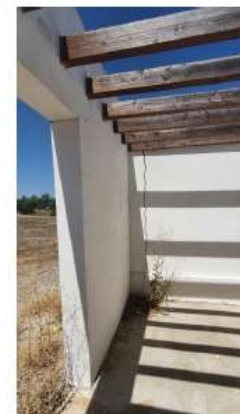
Φ.4, Φ.5: Μεγάλου εύρους διαμετρής κατακόρυφη εκτός επιπέδου καμπτική ρωγμή που διαπερνά την τοιχοποιία σε βάθος, ενώ ξεκινά από τη στέψη οροφής και καταλήγει στα θεμέλια. Στη Φ.4 φαίνεται η εν λόγω ρωγμή εξωτερικά, ενώ στη Φ.5 υποδεικνύεται η ίδια ρωγμή από την εσωτερική πλευρά του κτηρίου.
