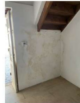
Φ.5, Φ.6: Εκτεταμένα προβλήματα ανιούσας υγρασίας με αποτέλεσμα το φούσκωμα, αποφλοιώση και την τοπική αποκόλληση του επιχρίσματος εσωτερικά του κτηρίου. Στη φωτογραφία δεξιά, ο τοίχος κάτω από τη σκάλα εφάπτεται της εξωτερικής σκάλας από φυσικό λίθο (βλέπε επόμενη Φ.7) η οποία εξωτερική σκάλα από πέτρα, φαίνεται να εγκλωβίζει την υγρασία η οποία εκτονώνεται στον τοίχο.
