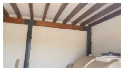
Φ.3: Αποψη εσωτερικού μεταλλικού σκελετού τμήματος του κτηρίου, όπου εδράζονται οι ξύλινες μορίνες της οροφής.
