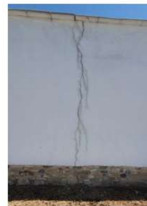
Φ.6, Φ.7: Έντονες κατακόρυφες ρωγμές που σχίζουν την τοιχοποιία σε όλο της το πάχος, ενώ ξεκινούν από τη στέψη οροφής και καταλήγουν στα θεμέλια. Οι εν λόγω ρωγμές παρατηρούνται στις γωνίες και στα σημεία ενώσεων με τους εγκάρσιους τοίχους αποτέλεσμα απουσίας περιμετρικού διαζώματος και ανεπαρκούς σύνδεσης μεταξύ εγκάρσιων τοίχων. Στη Φ.7 η ρωγμή φαίνεται να προκαλεί στροφική απόκλιση από την κατακόρυφο.
