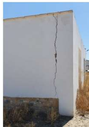
Φ.4, Φ.5: Μεγάλου εύρους διαμετρής κατακόρυφη εκτός επιπέδου καμπτική ρωγμή που διαπερνά την τοιχοποιία σε βάθος, ενώ ξεκινά από τη στέψη οροφής και καταλήγει στα θεμέλια. Στη Φ.4 φαίνεται η εν λόγω ρωγμή εξωτερικά, ενώ στη Φ.5 υποδεικνύεται η ίδια ρωγμή από την εσωτερική πλευρά του κτηρίου.
