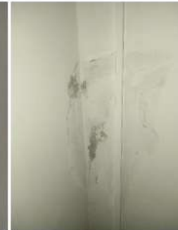
Φ.7: Τοπικά εκτεταμένα προβλήματα υγρασίας
