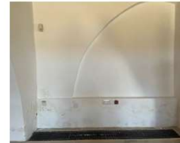
Φ.3, Φ.4: Εκτεταμένα προβλήματα ανιούσας υγρασίας με αποτέλεσμα το φούσκωμα και τοπική αποκόλληση του επιχρίσματος εσωτερικά του κτηρίου.
