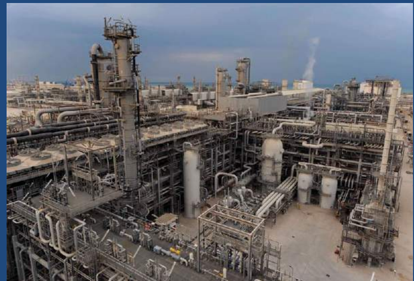
Pearl GTL Plant της Shell στο Qatar Το μεγαλύτερο παγκοσμίως
