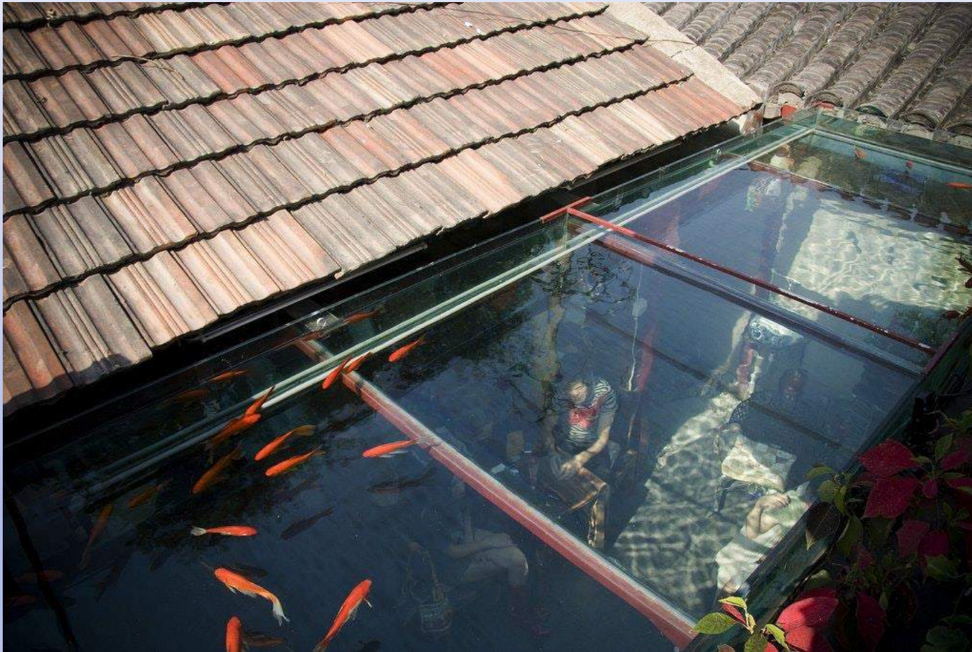
Οροφή με αποθήκευση νερού
