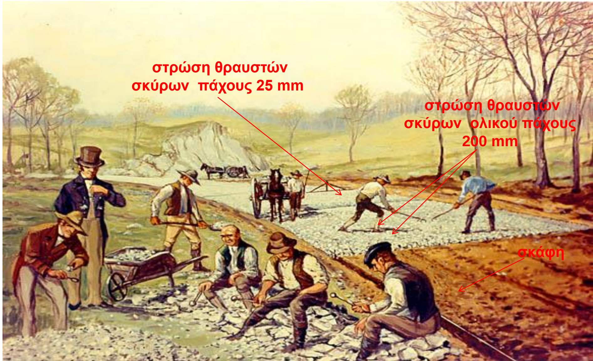
Κατασκευή δρόμου τύπου McAdam
