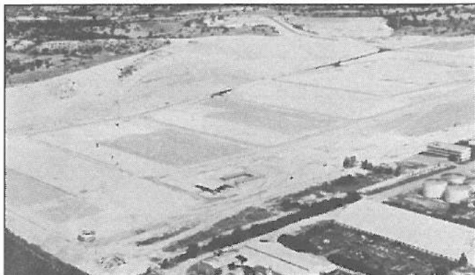
Αποψη του γηπέδου του νέου Ηλεκτροπαραγωγού Σταθμού της ΑΗΚ στο Βασιλικό.
