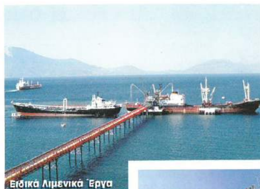
Ειδικά Λιμενικά Έργα
