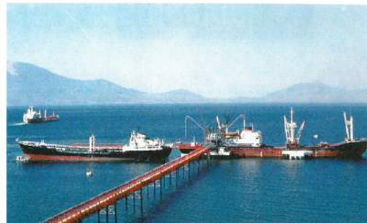
Ειδικά Λιμενικά Έργα
