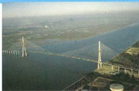
Η κρεμαστή γέφυρα της Νορμανδίας στη Γαλλία στεγανοποιήθηκε με το σύστημα INDEX NOVA
