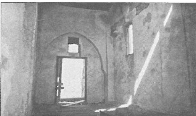
Αποψη εσωτερικού χώρου στον όροφο
