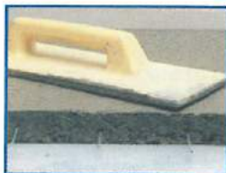
MAPECEM Πλακόστρωση μετά από 4 ώρες.
