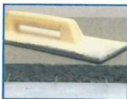
MAPECEM Πλακόστρωση μετά από 4 ώρες.
