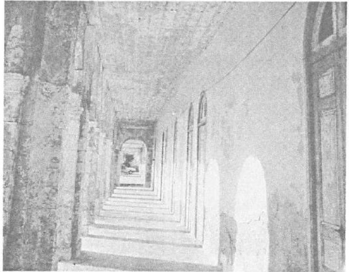
Η νότια στοά των βοηθητικών κτιρίων της μονής Αποστόλου Αντρέα
