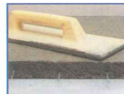
MAPECEM Πλακόστρωση μετά από 4 ώρες.
