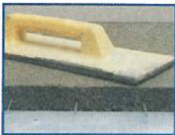
MAPECEM Πλακόστρωση μετά από 4 ώρες.
