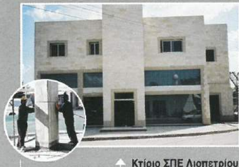
Κτίριο ΣΠΕ Λισπετρίου
