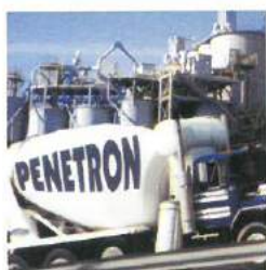
Penetron Admix κατά την σκυροδέτηση
