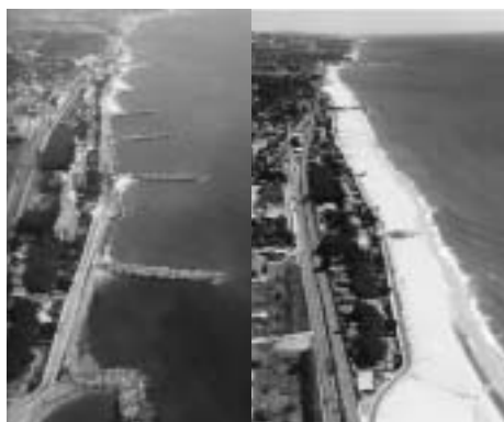
Ακτή στην Καταλωνία. Κατεδάφιση κυματοθραυστών και αναπλήρωση ακτής, 1995
