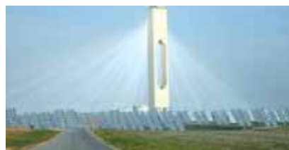
Ηλιοθερμική τεχνολογία ηλεκτροπαραγωγής με ηλιακό πύργο και ηλιοστάτες.
