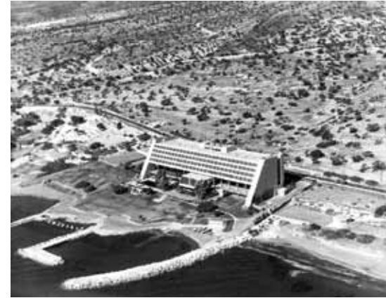
Ξενοδοχείο Αμαθούς στη Λεμεσό.
