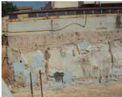
Εκσκαφή επί εφαιπόμενης οικοδομής.
