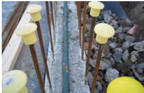
Ταινία στεγάνωσης (waterstop) σε οριζόντιο αρμό.
