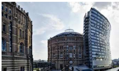
Το Gasometer B εξωτερικά και η σχέση του με την "Ασπίδα".
