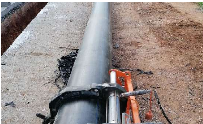
Εγκατάσταση αγωγού άντλησης για τη μεταφορά λυμάτων από την Κοινότητα της Άχνας προς τον Σταθμό Επεξεργασίας Λυμάτων.
