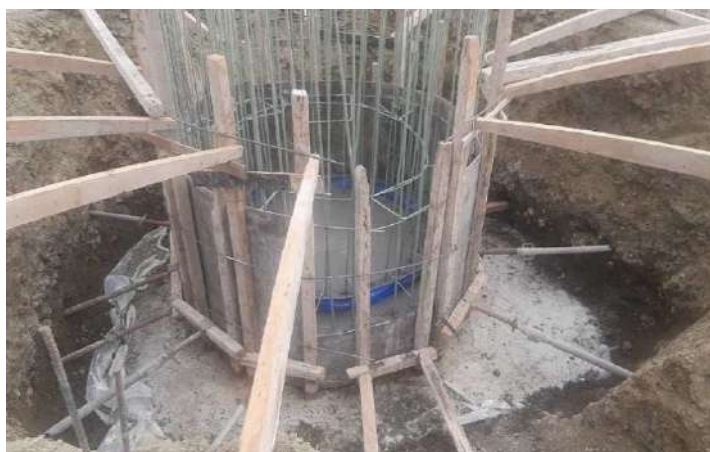
Σκυροδέτηση σε πεδινόπλακα του κτιρίου προεπεξεργασίας (Σολιά).
