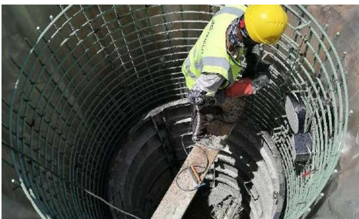
Χωματουργικές εργασίες για τη διαμόρφωση των δεξαμενών μακροπρόθεσμης αποθήκευσης ανακυκλωμένου νερού (Αποχετευτικό Κοκκινοχωρίων).
